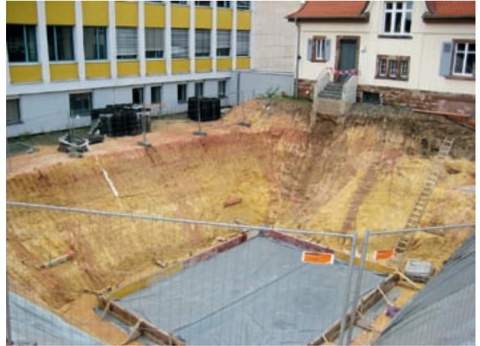
Betonboden für das Ultraschall-Messbecken, eingelassen in die Sandsteinschichtlagen des Untergrunds.
