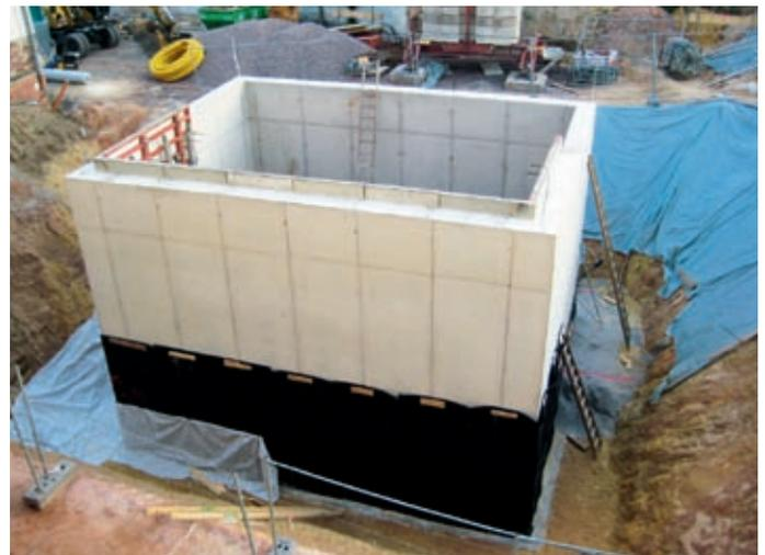
Seitenwände des Beckens, mit schwarzen Schwingungsentkopplungsmatten.
